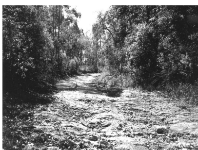
Figura 5: ponto 8 erosão por impacto, laminar e em sulco de severidade média
