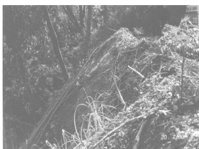
Figura 7: ponto 13 erosão laminar em conjunto com movimento de massa com caráter grave
